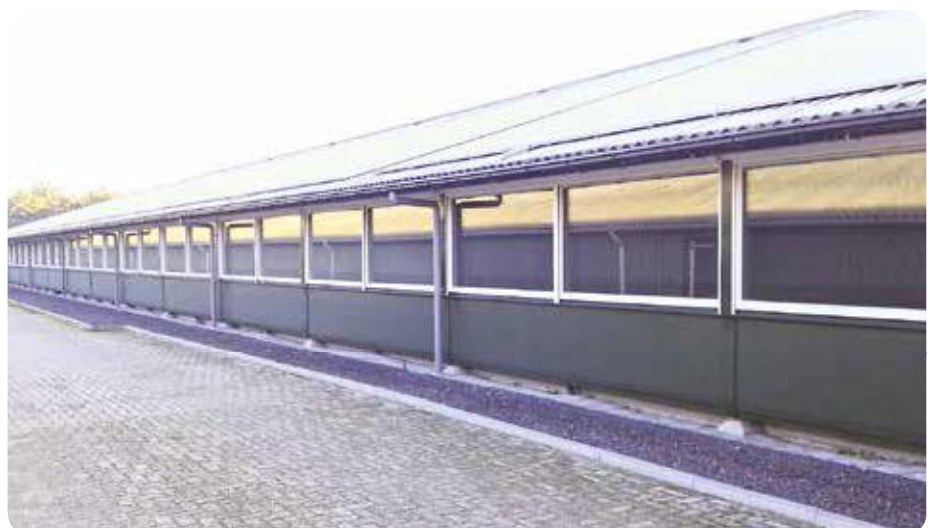
Door de grote ramen in de zijwanden bekomt men een “open”stal. Bemerkt ook de rolluiken.
