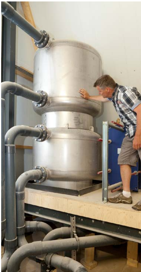
Der Luftwäscher reinigt die Stallluft und reduziert den Ammoniak- und Feinstaubgehalt auf ein Minimum.
